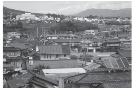
長野県飯田市の民間ファンドで設置された太陽光パネル群
