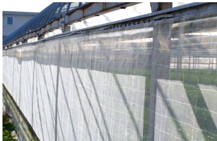
防虫ネット設置（※屋根被覆前）
